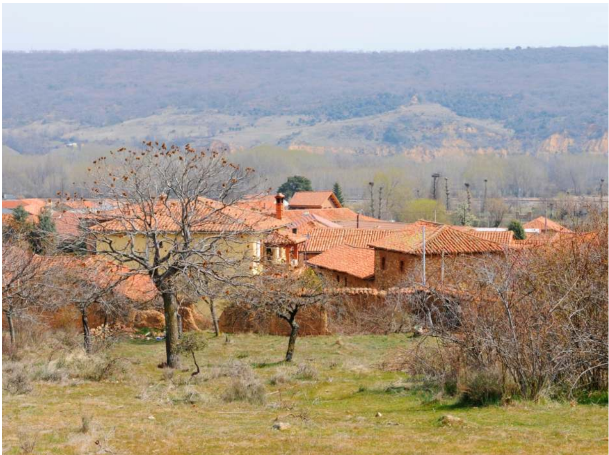
Construcciones tradicionales. Santibáñez del Bernesga (El Bernesga)
