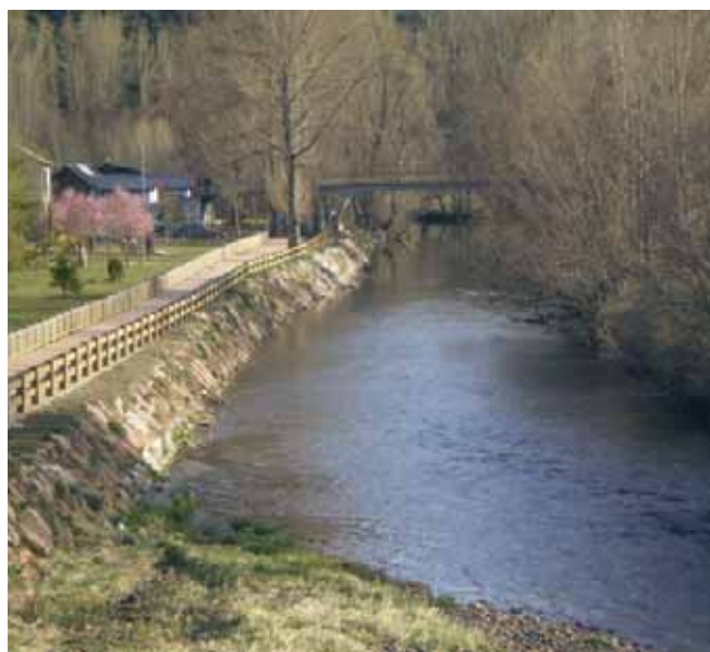
Tramo del río Luna a su paso por Canales - La Magdalena
