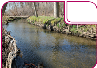
Presas y canales
