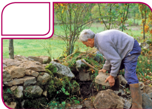
Muro de piedra
